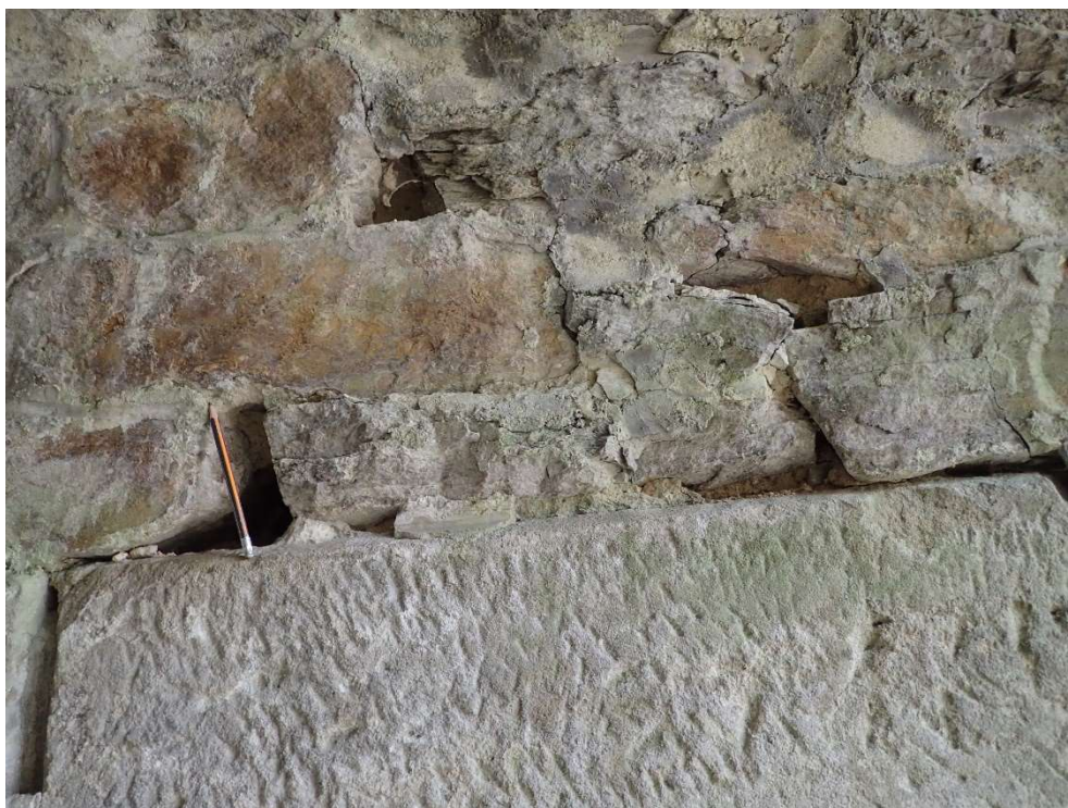
Foto 4: Degradování kamenného zdiva včetně spárování
