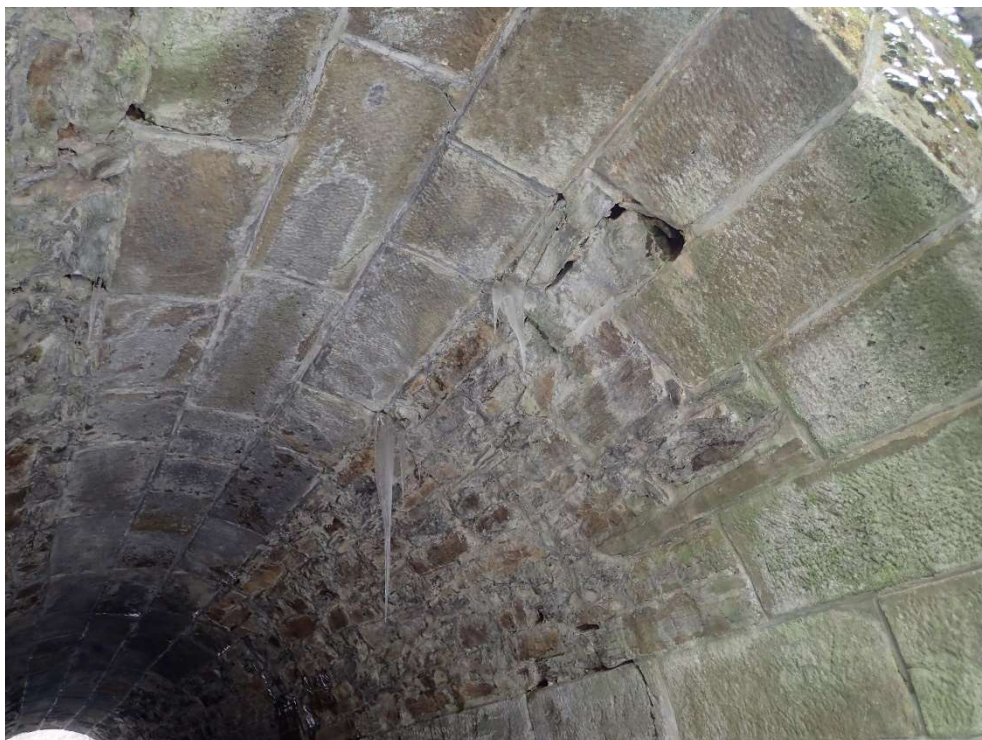
Foto 3: Patrné průsaky v klenbě, vypadané spárování
